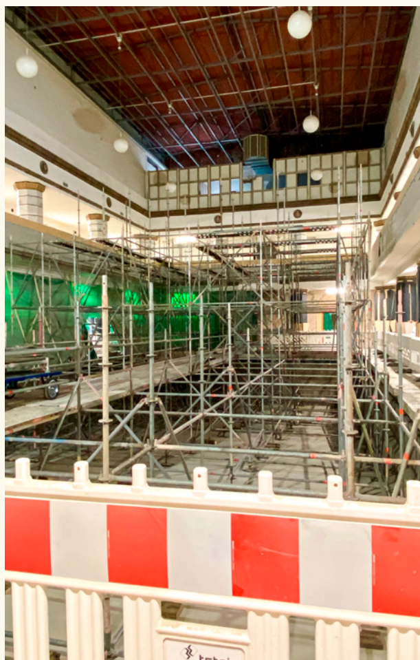
Die Sanierung des Männerbeckens im Historischen Stadtbad.
