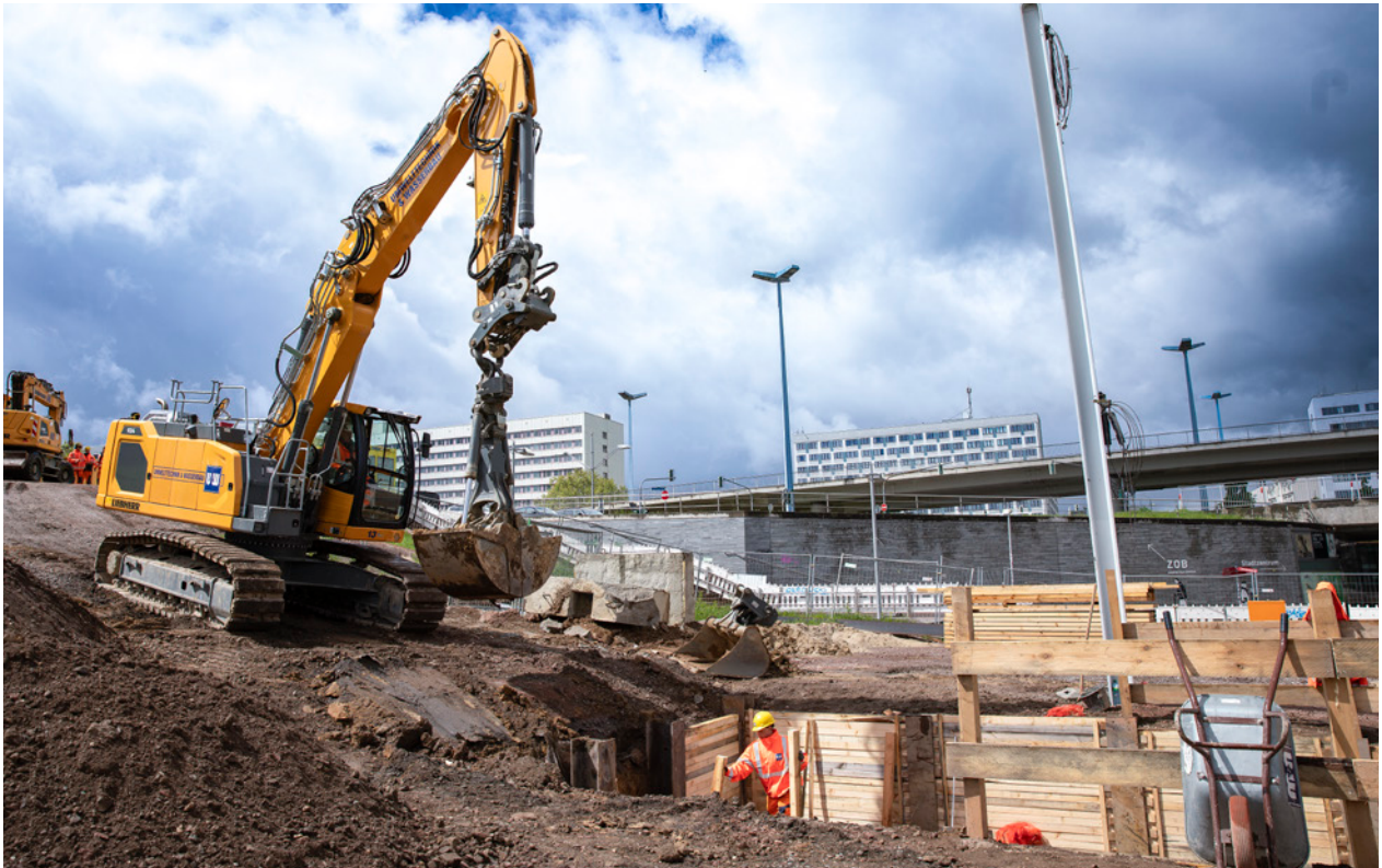
Mit den Bauarbeiten am Riebeckplatz wird der Ausbau der technischen Infrastruktur vorangetrieben.
