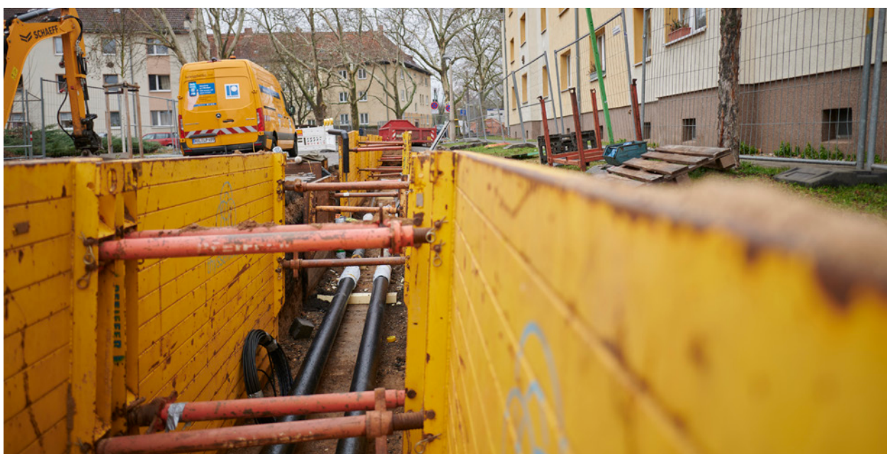
Fernwärmeausbau in der Robert-Mühlporfte-Straße.
