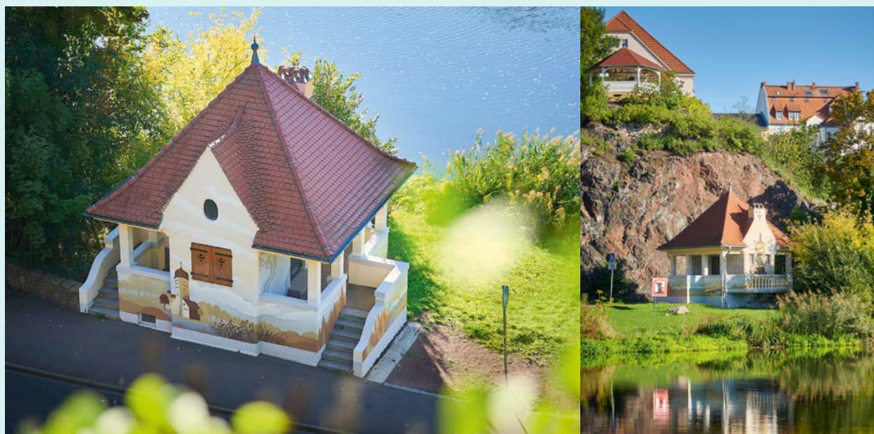
Die Silhouette der Stadt macht das denkmalgeschützte Abwasserpumpwerk Talstraße zu einem Hingucker.
