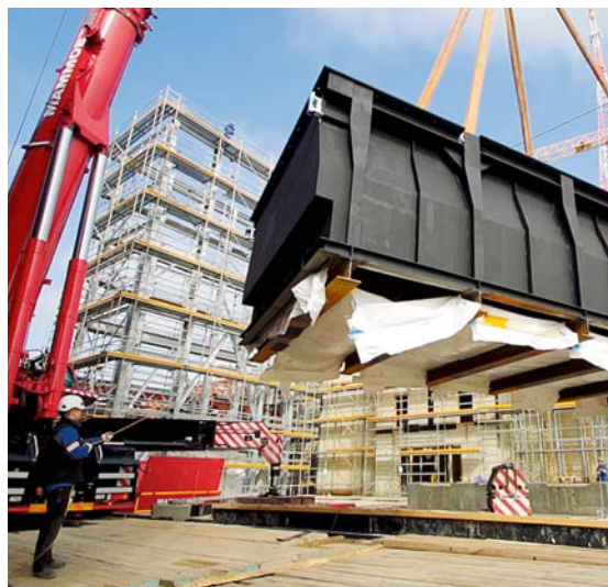
Neubau des Blocks C 2019 im Energiepark Dieselstraße. Hier der Einbau des Abhitzewärmetauschers. Foto: Agentur Kappa, M. Sorge
