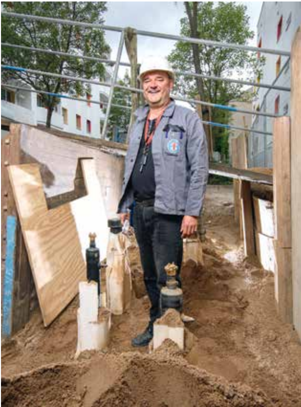
Bauleiter Michael Körner von der Tief- und Spezialbau Halle GmbH verantwortet die Baumaßnahmen im Paulusviertel.
