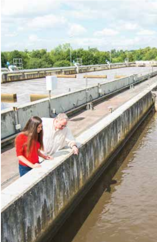
Die Kläranlage ist viel größer als Laura sich das vorgestellt hatte.
