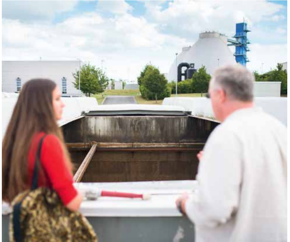
Zufall und Glücksfall: Während Wartungsarbeiten kann Laura in das dafür geöffnete Becken der Vorklärung schauen.
