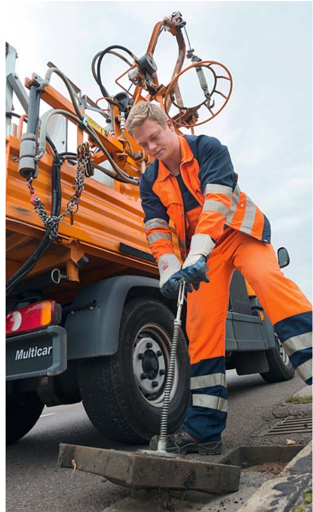
HWS-Mitarbeiter Martin Zabel bedient das Spezialfahrzeug.
